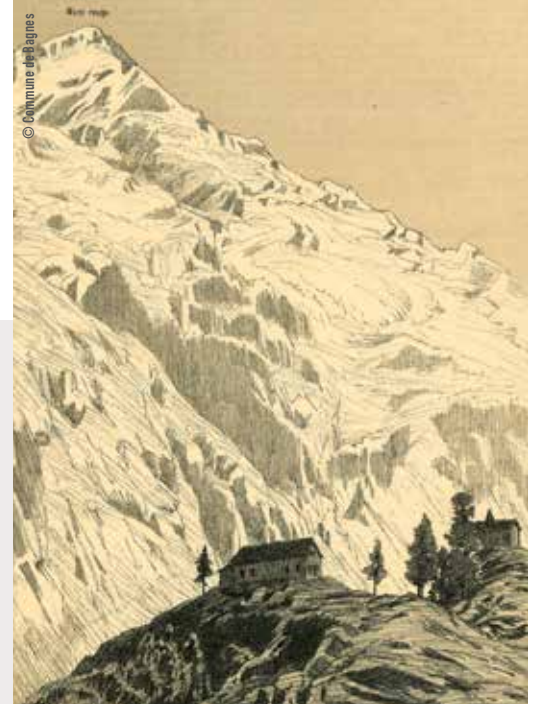
GRAVURE DE L'HÔTEL DU GLACIER DU GIÉTROZ VERS 1875 REPRODUITE DANS LE « NEUE ALPENPOST » BD. XII. NR. 3
